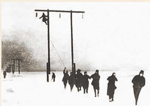
Линия электропередачи на Ладозском озере
