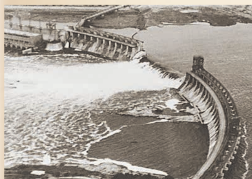
Разрушенная войной ДнепротЭС
