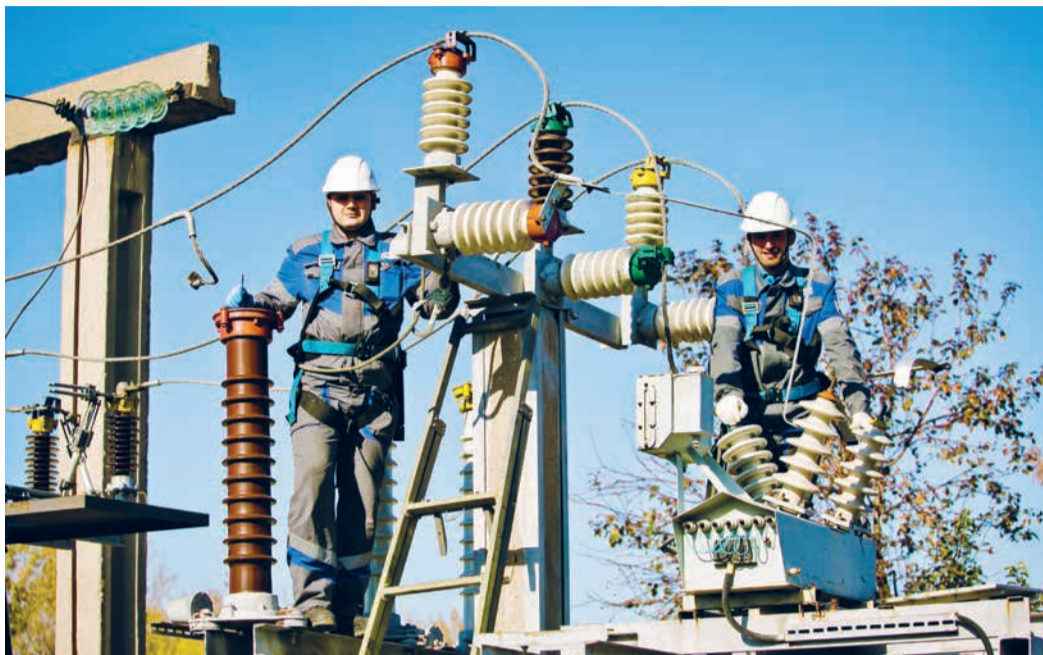
Текущий ремонт на ПС 110/35/10 «Дедуровка»
