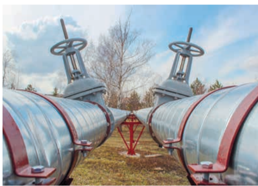
Участок построенной тепловой сети
