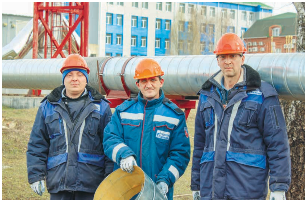
Работы на объекте выполнял персонал цеха энерговодоснабжения п. Рыздвяный
