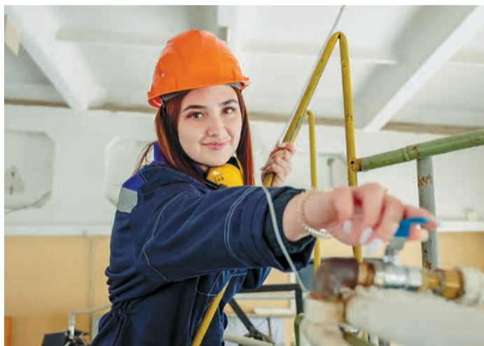
Оператор котельной Наталья Колошина
