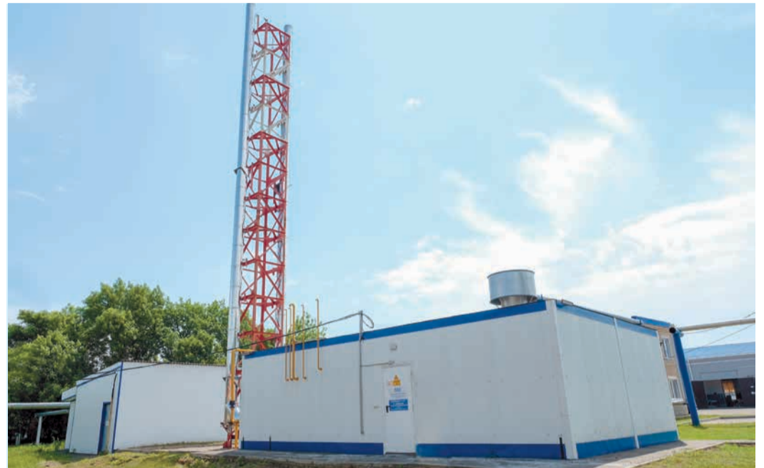
Котельная в станции Каневской, Краснодарский край
