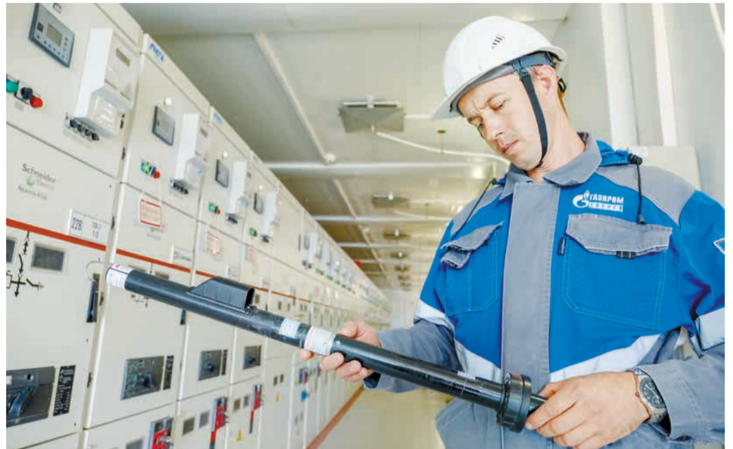
Сергей Тенев выполняет проверку указателя напряжения
