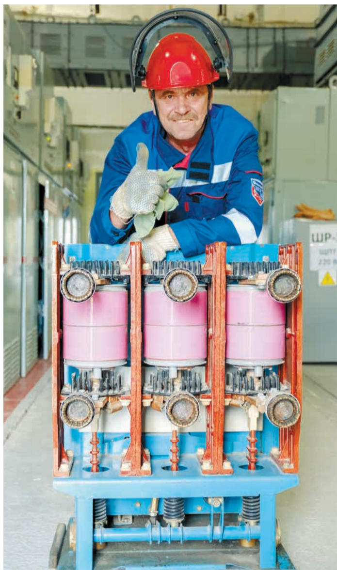
Электромонтер оперативно-выездной бригады участка электроснабжения г. Саратова Александр Шаров
