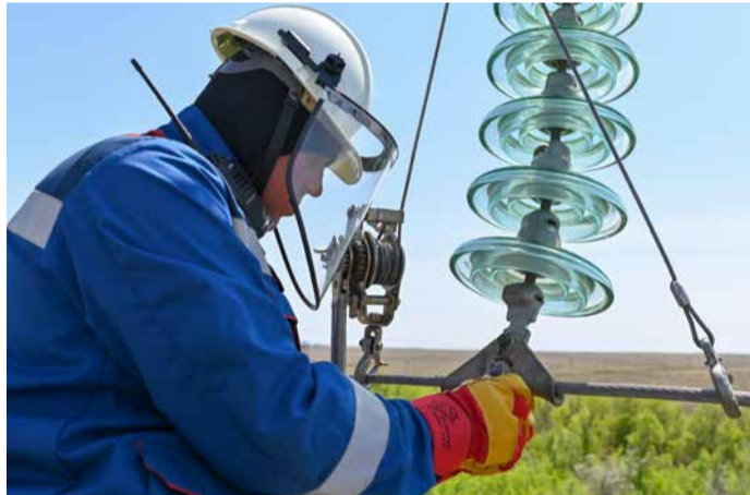
Верховой осмотр сцепной арматуры
