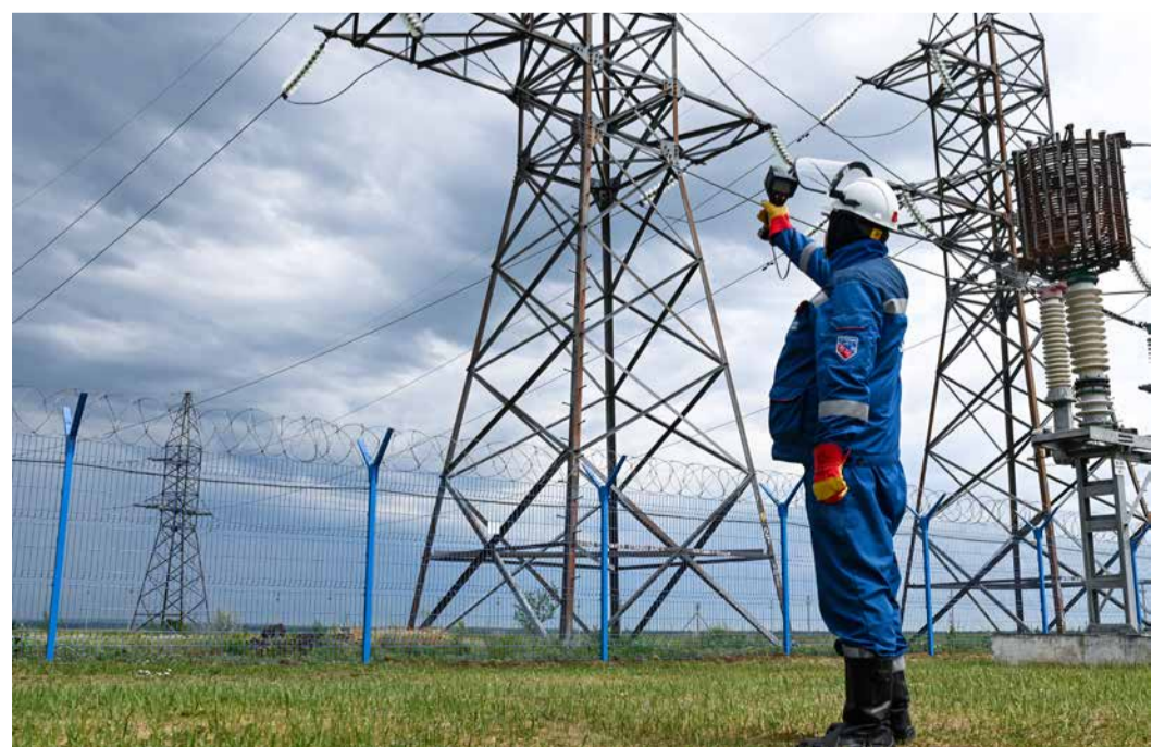
Осмотр воздушной линии с применением тепловизионного оборудования
