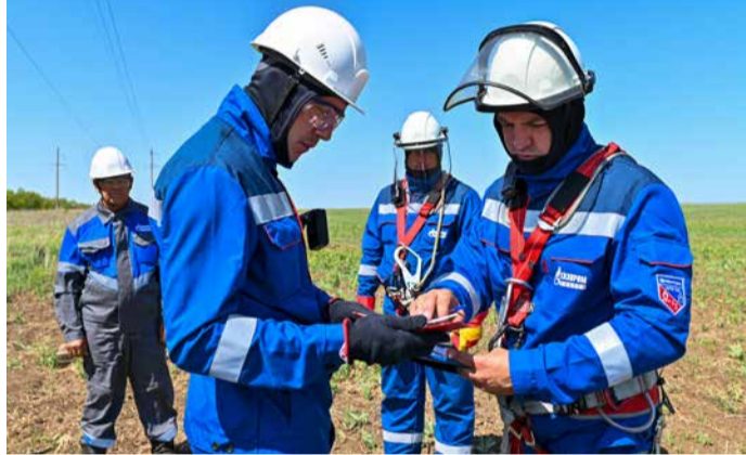
Ответственный руководитель работ проверяет удостоверения по электробезопасности
