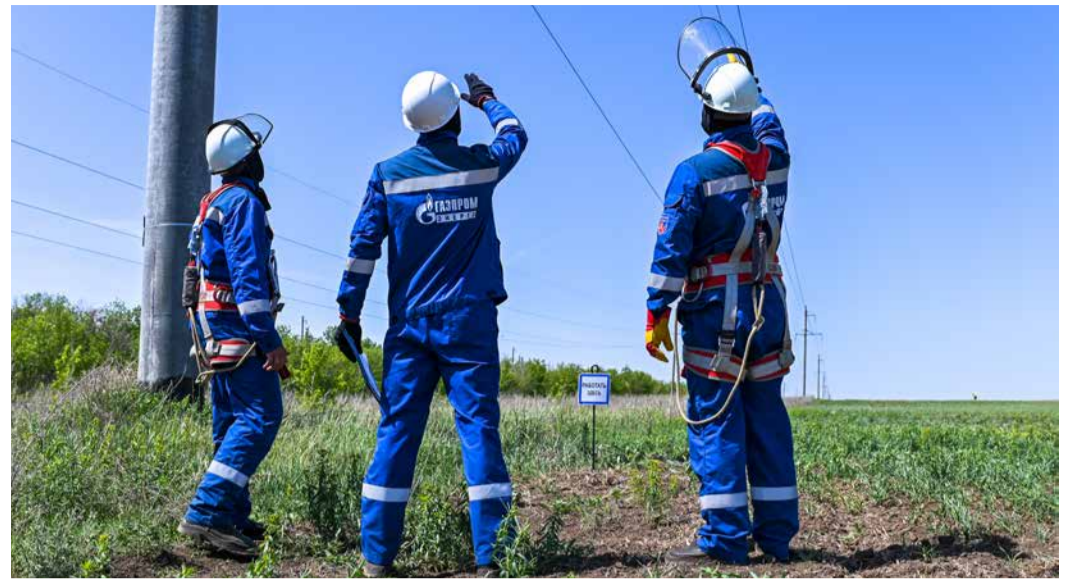
Визуальный осмотр состояния ВЛ
