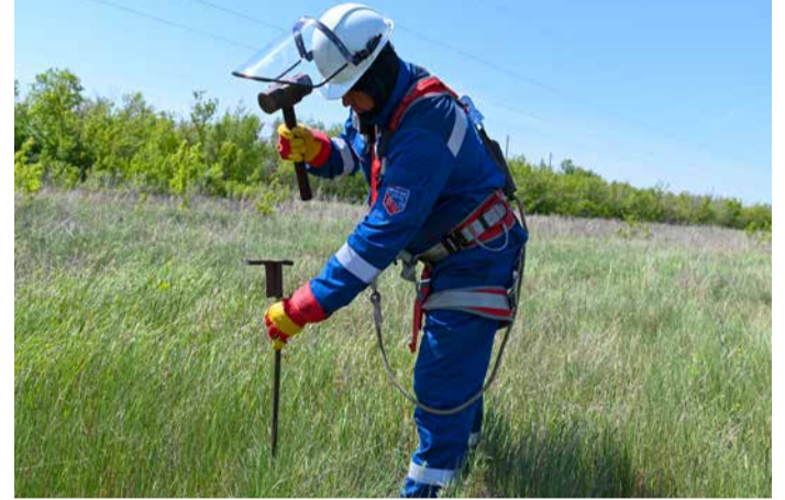
Погружение заземлителя в грунт
