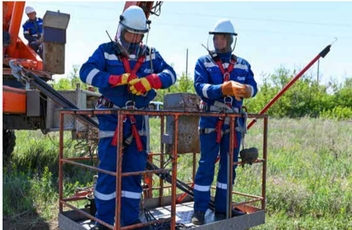
Электромонтеры готовятся к подъему для верхового осмотра
