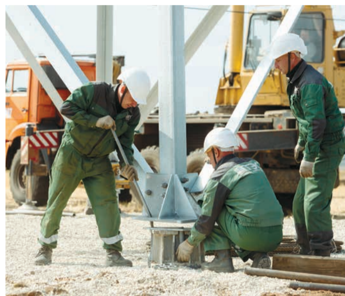
Посадка опоры на фундамент
