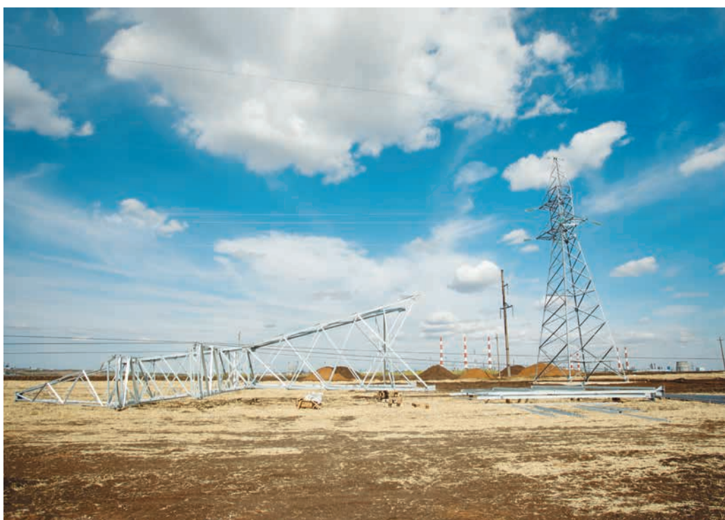
Подготовка очередной опоры к монтажу
