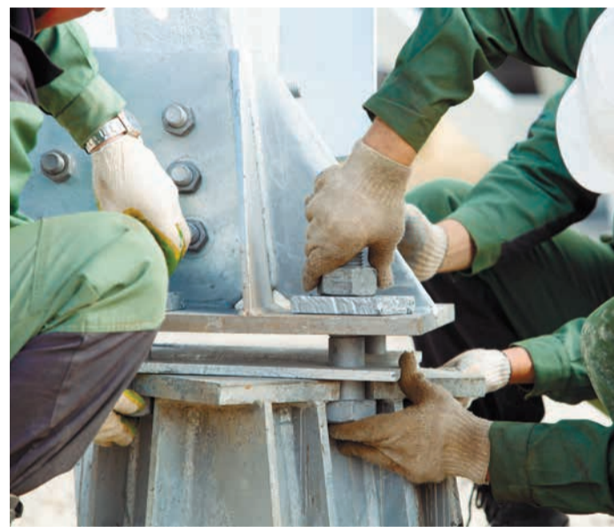
Затягивание болтовых соединений
