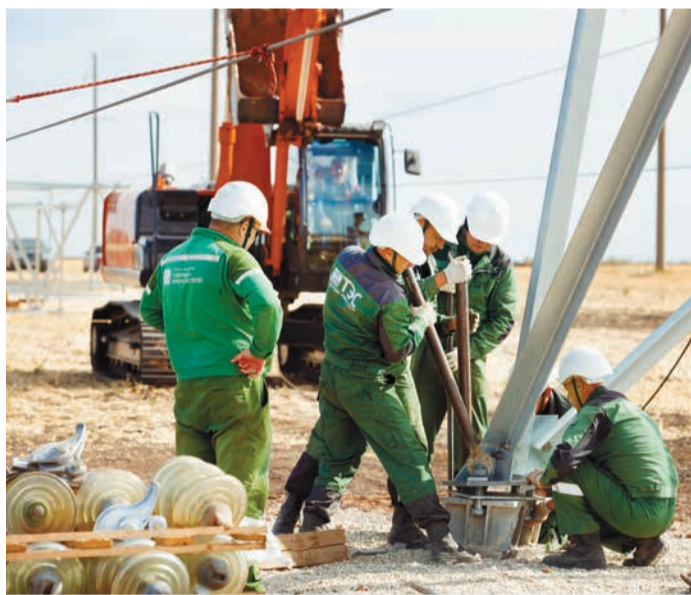
Подгонка посадочных отверстий
