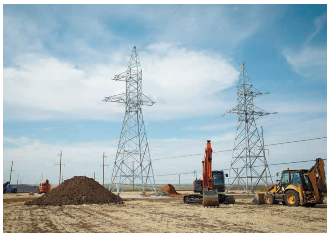
Строительная площадка (общий вид)
