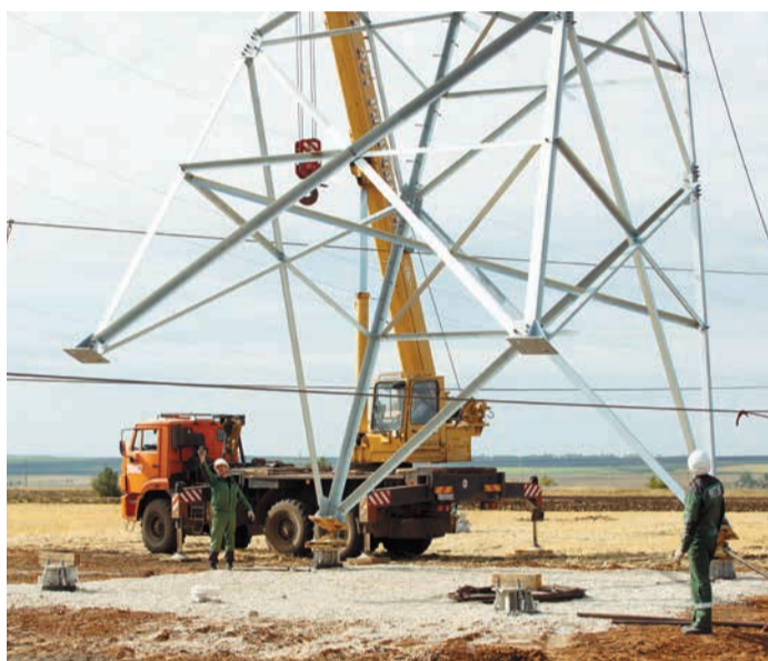
Направление опоры на посадочное место
