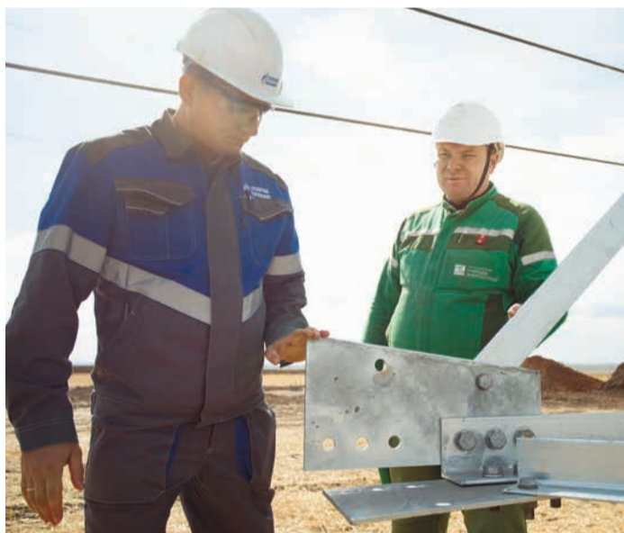
Осмотр опоры перед установкой Заказчиком
