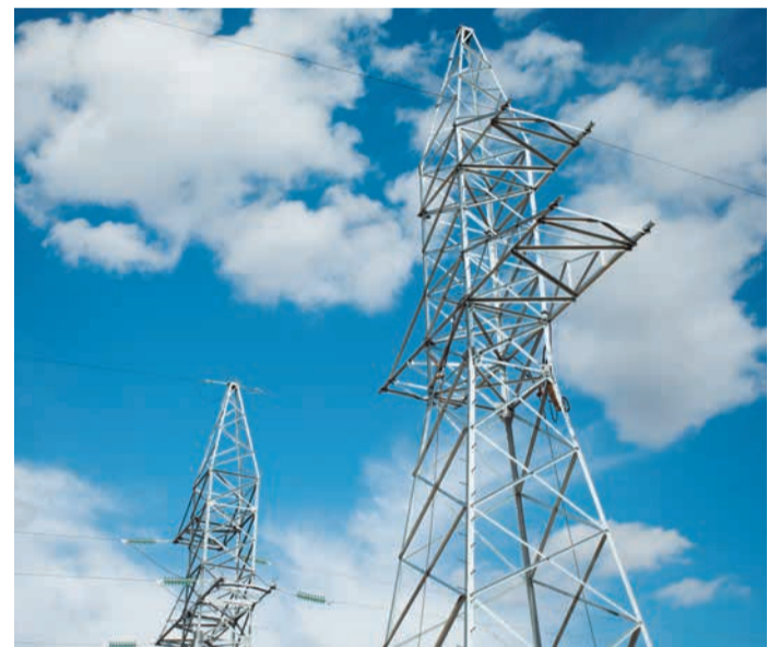
Следующий этап – монтаж провода
