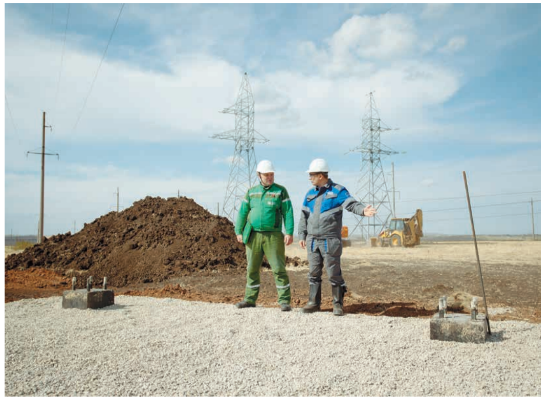
Строительный контроль фундаментов
