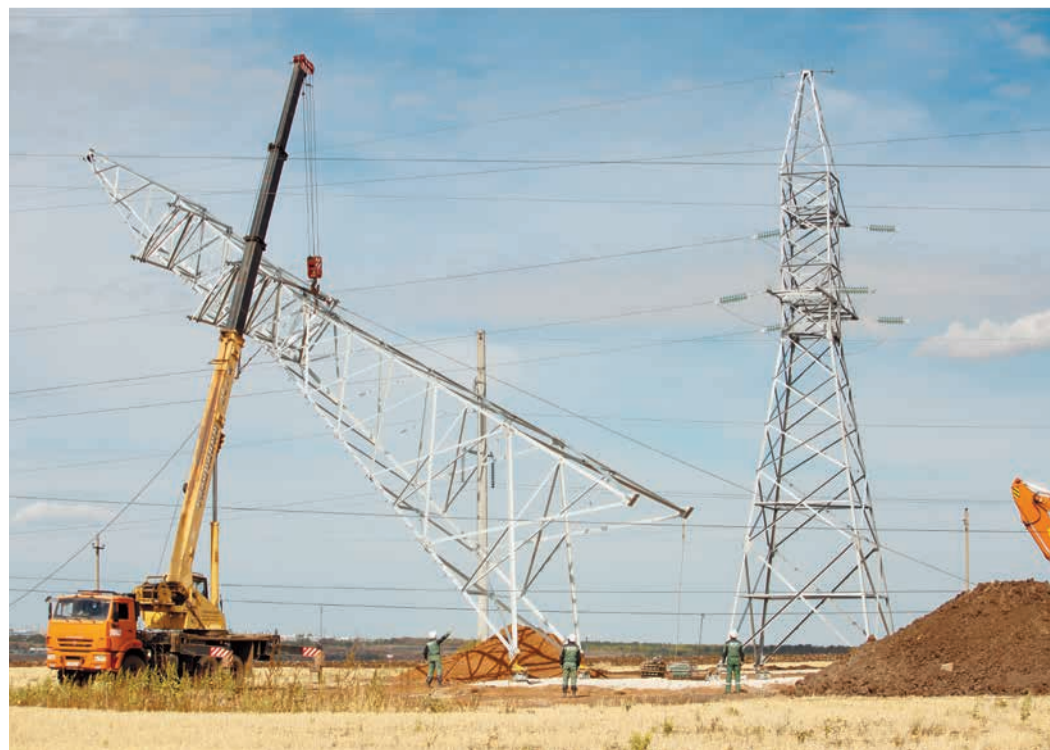
Процесс подъема опоры
