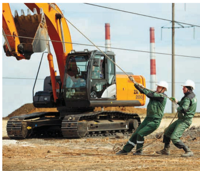
Процесс монтажа опоры
