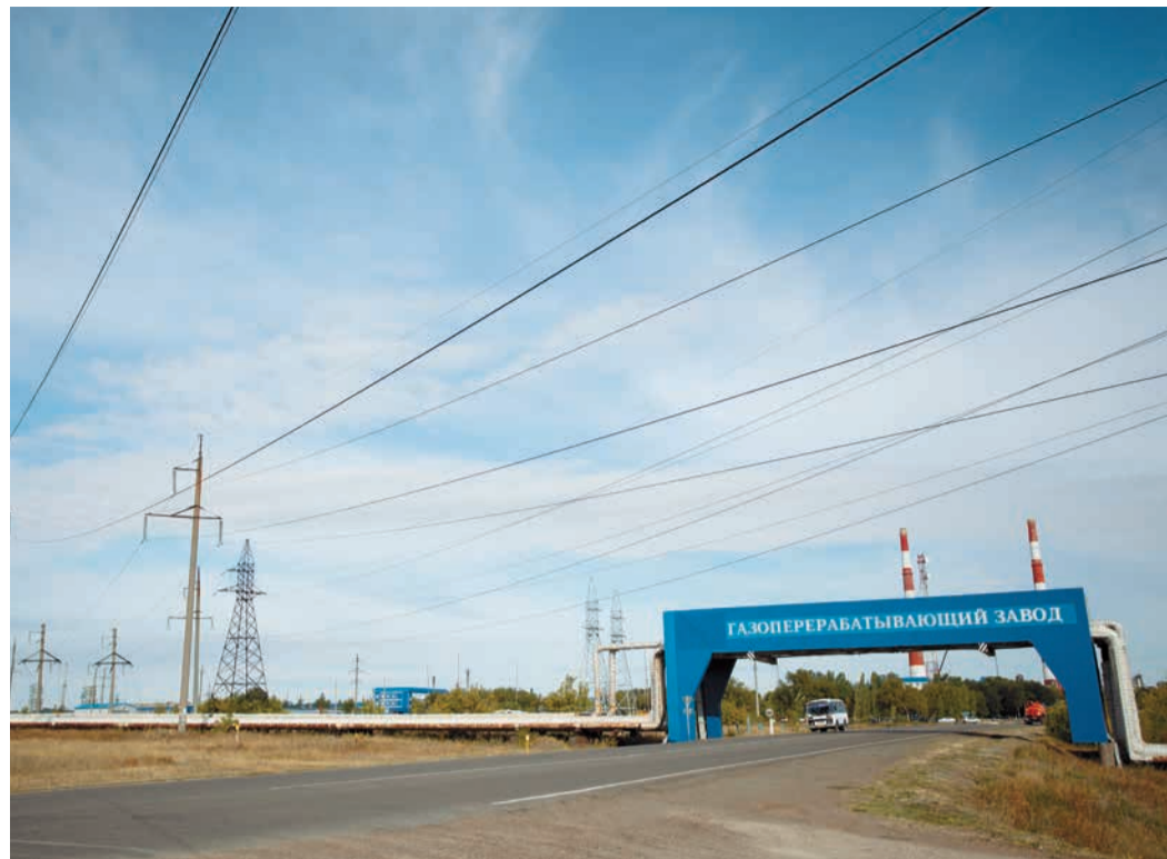
Сети ЮУФ в районе Газзавода
