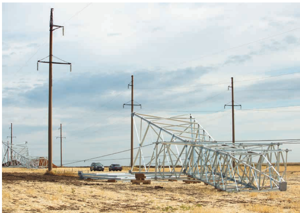
Собранная опора, готовая к монтажу
