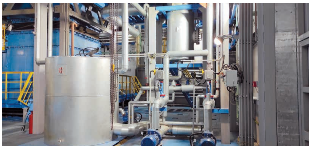
Дренажная емкость УТО в машинном зале ЭСН
