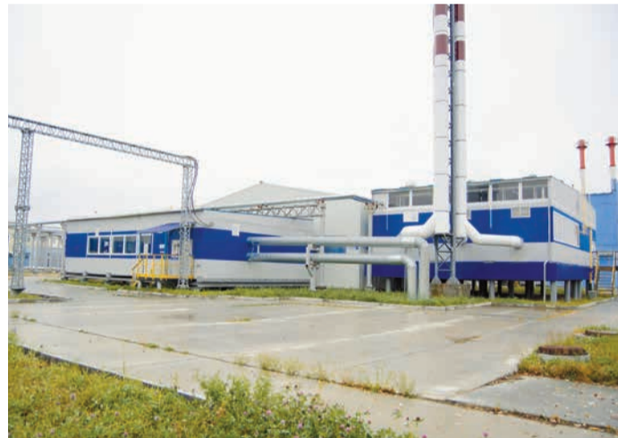
Котельная 72 МВт п. Пангоды
