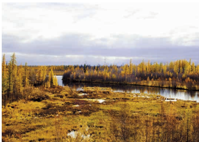
ВЛ-110 кВ в районе Ныдинского водозабора
