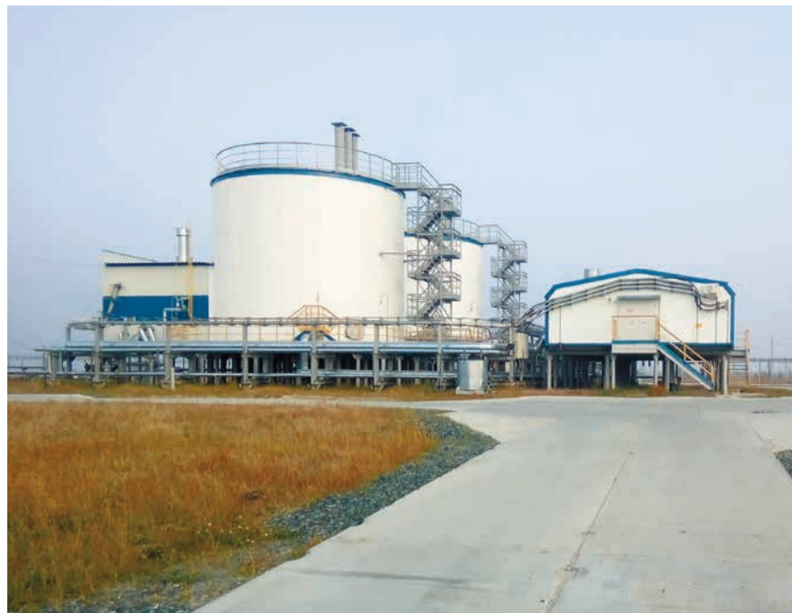
Водонасосная ВЖК, Медвежинское НГКМ
