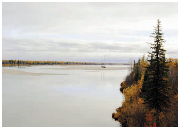
ВЛ-110 кВ, переход через р. Ныда
