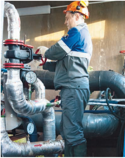
Тепловая камера, п. Заполярный. Слесарь-ремонтник Суворов В.В.
