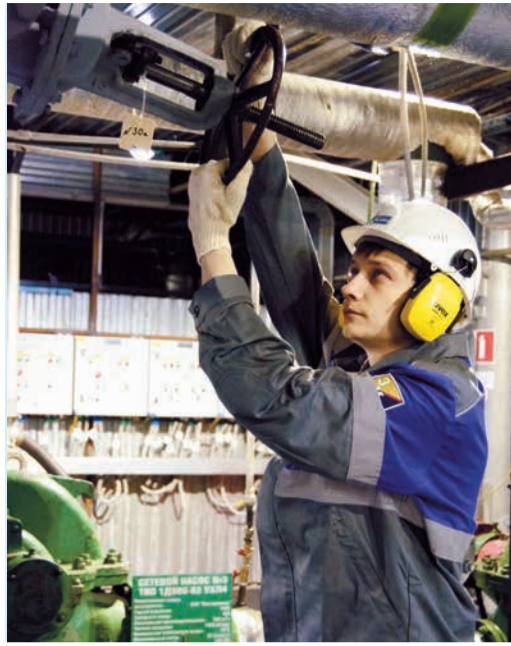
Котельная ДКВР, п. Пангоды. Слесарь-ремонтник Мартыничук С.В.
