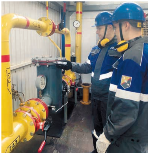
Слесарем по эксплуатации и ремонту газового оборудования (на фото слева направо) Романом Ковальчиком и Игорем Гертум выполняется работа по выявлению утечек газа. Осуществляется с помощью газоанализатора путём проверки герметичности разъемных соединений
