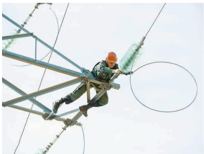
Затяжка болтовых соединений изоляционной подвески
