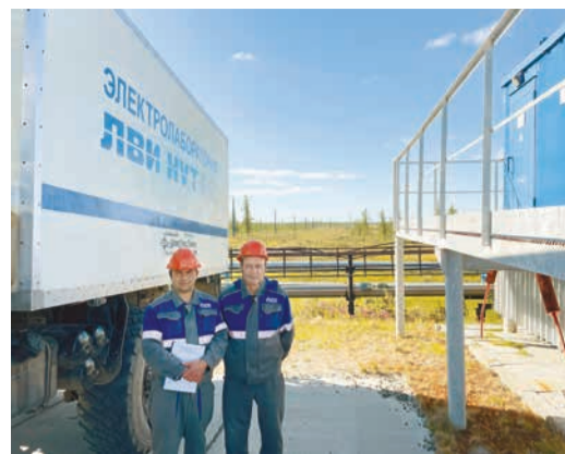
Раиль Арасланов – электромонтёр по испытаниям и измерениям, Олег Яковлев – электромонтёр по ремонту аппаратуры релейной защиты и автоматики на фоне блок-боксов обогрева и передвижной лаборатории высоковольтных испытаний перед проведением профилактических испытаний
