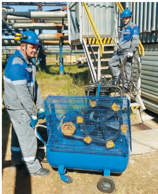
Слесарь по ремонту оборудования котельных и пылеприготовительных цехов Артём Гарцер и слесарь по ремонту оборудования котельных и пылеприготовительных цехов Филипп Золотухин выполняют работы по гидроневматической промывке систем отопления зданий на территории котельной № 2
