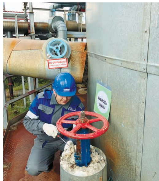
Подготовка резервуара к промывке (слесарь АВП ЦВиК Рустам Шайхутдинов)
