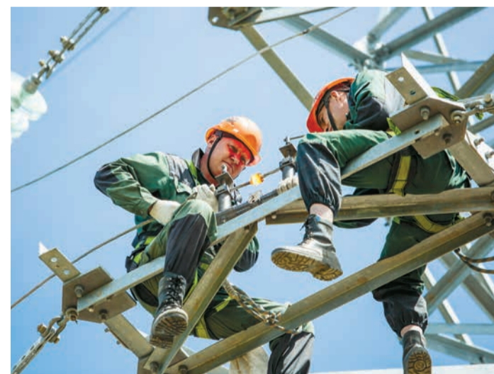
Соединение проводов методом термитной сварки
