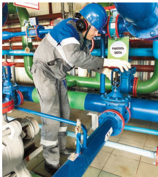
Переключения в насосной станции перед промывкой резервуара (слесарь АBR ЦВиК Владимир Атягин)
