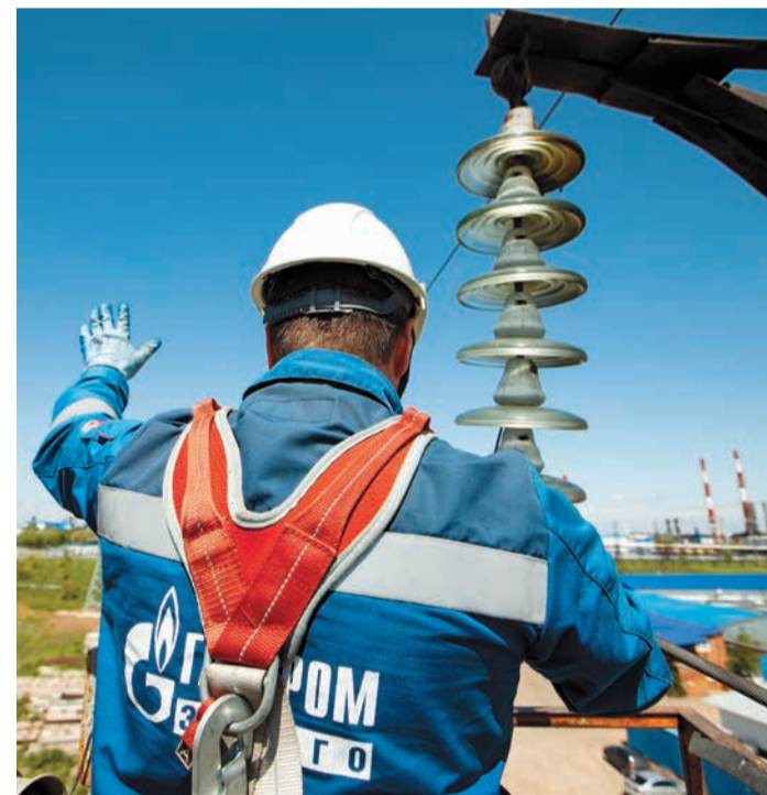
Работа электромонтёров-линейщиков на высоте
