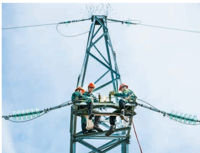
Сварка соединительных шлейфов на опоре ВЛ
