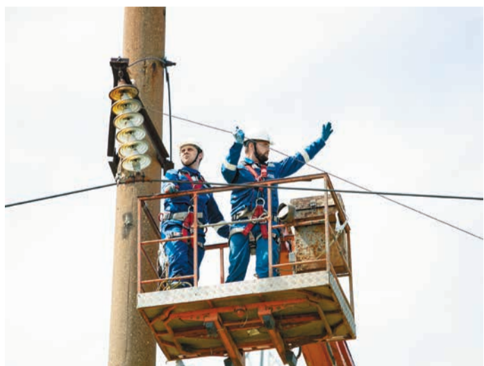
Демонтаж грозозащитного троса в месте врезки во вновь построенную ВЛ
