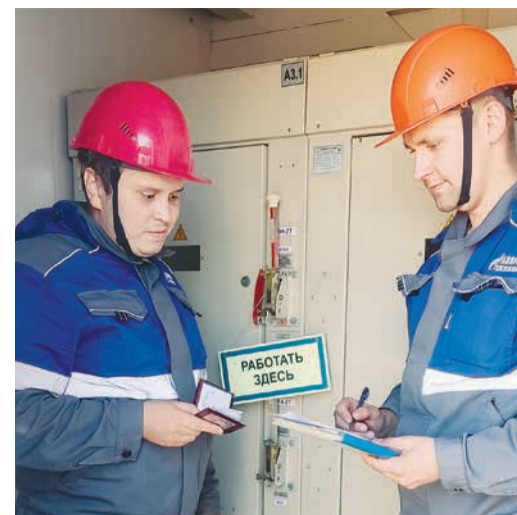
Николай Дамочкин (электромонтёр по ремонту и обслуживанию электрооборудования) производит инструктаж электромонтёру по ремонту и обслуживанию электрооборудования Денису Алексеёву
