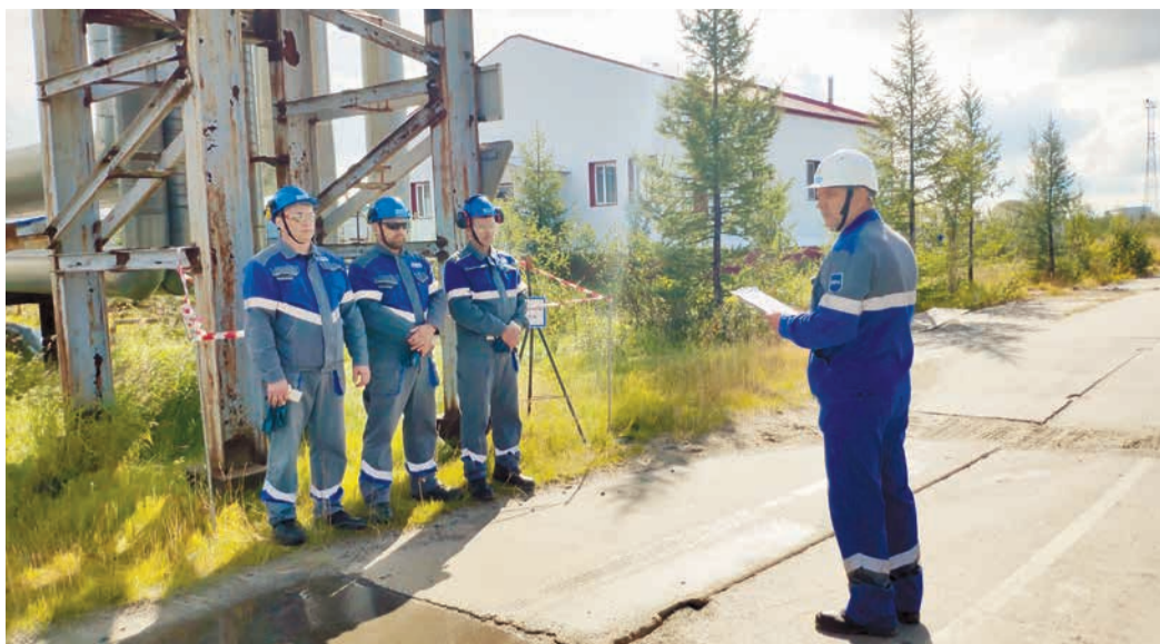
Проведение инструктажа перед промывкой трубопровода ХВС (мастер ЦВиК Сергей Волынский, слесарь АBR ЦВиК Павел Митрофанов, слесарь АBR ЦВиК Алексей Шишкин, слесарь АBR ЦВиК Андрей Соколов)
