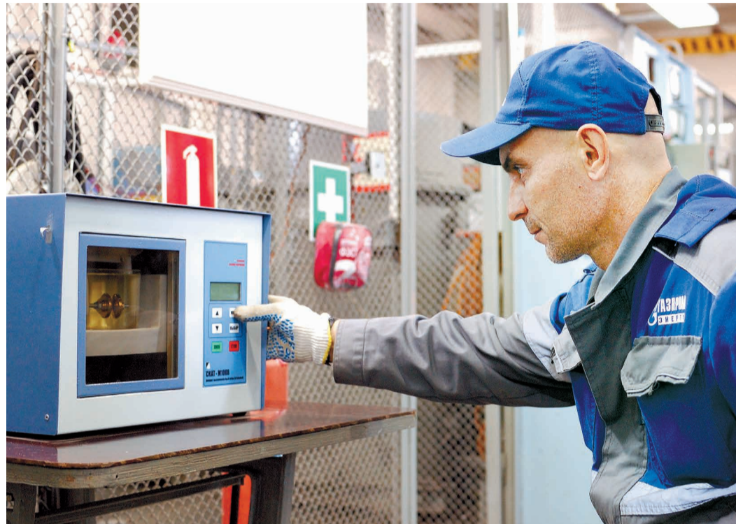
Проверка трансформаторного масла на пробой. Автор Алексей Митин, инженер 1-й категории ПЭТЛ СЭС, Южно-Уральский филиал
