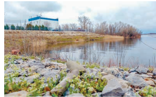
Водозабор на реке Бузан, Астраханская область, Южный филиал
