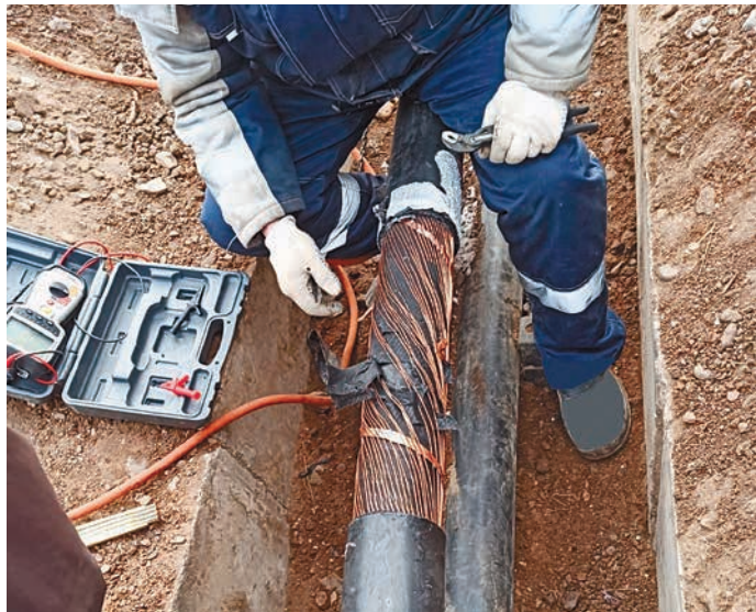
Ремонт КВЛ-220 НСПГУ – Ашкадар
