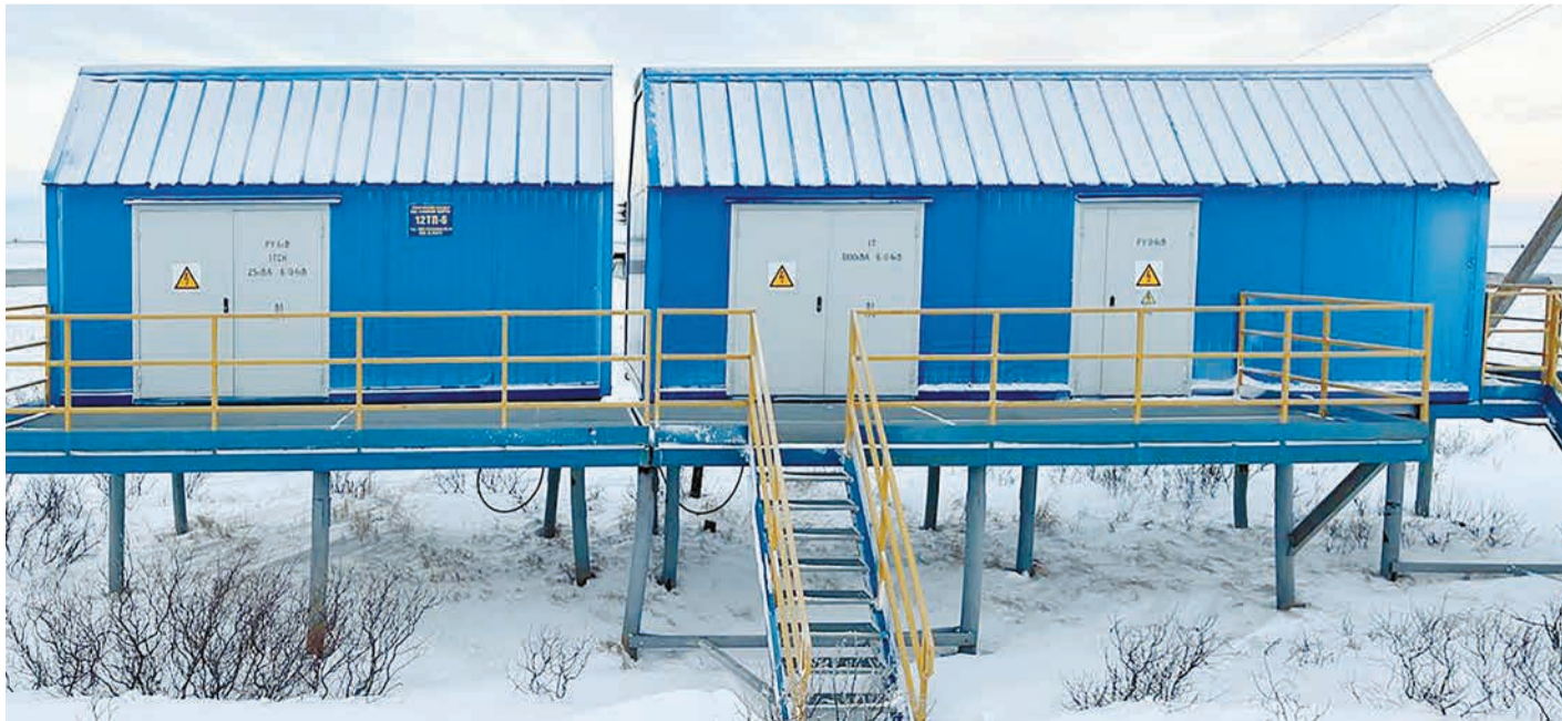
Отремонтированный блок-бокс электрообогрева водоводов
