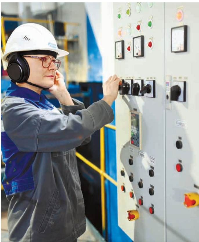
Машинист насосных установок третьего разряда Южно-Уральского филиала Наталья Романова производит запуск ЧРП 6 кВ на Чернореченском водозаборе
